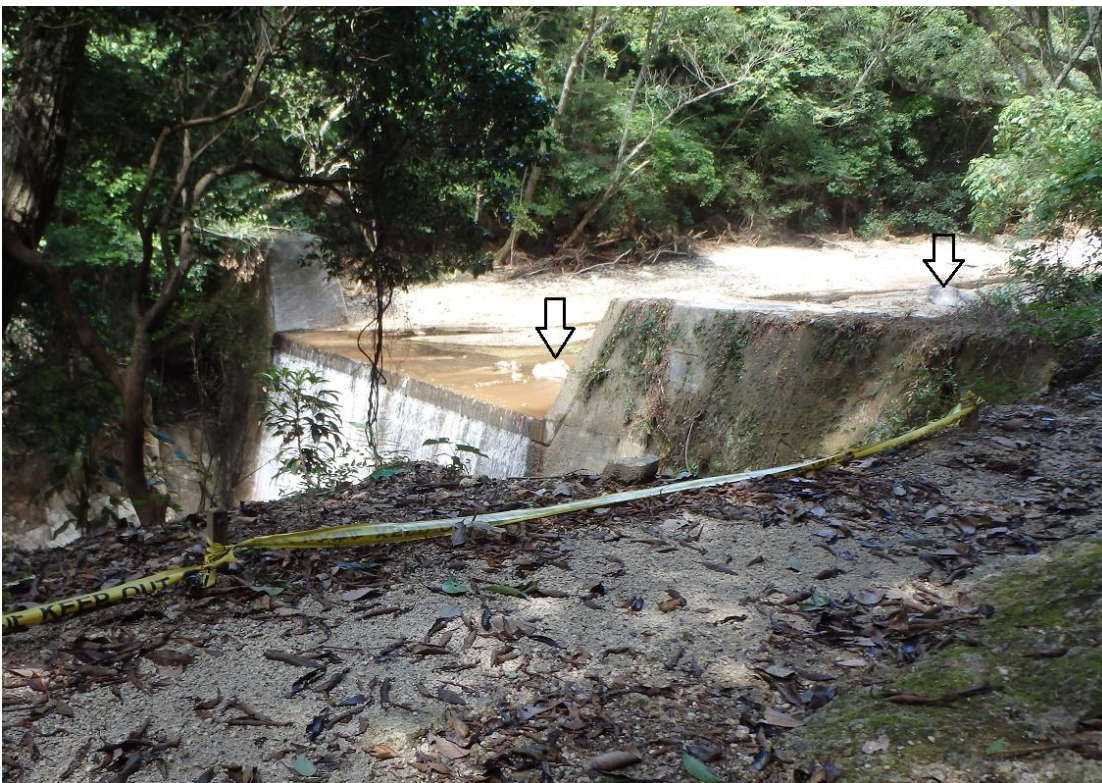
図15 巨レキ（矢印）を含む大量の砂が堆積した堰堤（図12のb地点）
