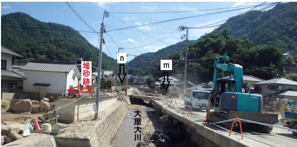
図4 厚さ1～2mの砂が堆積した大屋大川沿い 呉市天応（m地点西側から上流を見る）
