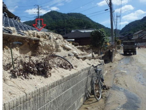
図6 屋根まで堆積した砂礫 (n地点)
