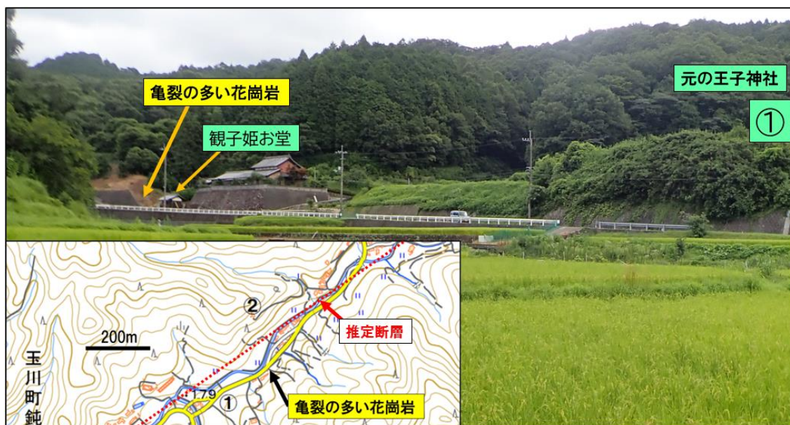
図 5-2. 亀裂の多い花崗岩の露頭と元の王子神社の位置関係 亀裂の多い花崗岩の露頭のある法面にはコンクリートブロックの擁壁が築かれ、崩壊を防ぐ手立てがとられている。元の王子神社があったあたりの斜面は、その延長線上であり、同様に「流れ盤」状に亀裂が入った斜面であることが推定できる。
