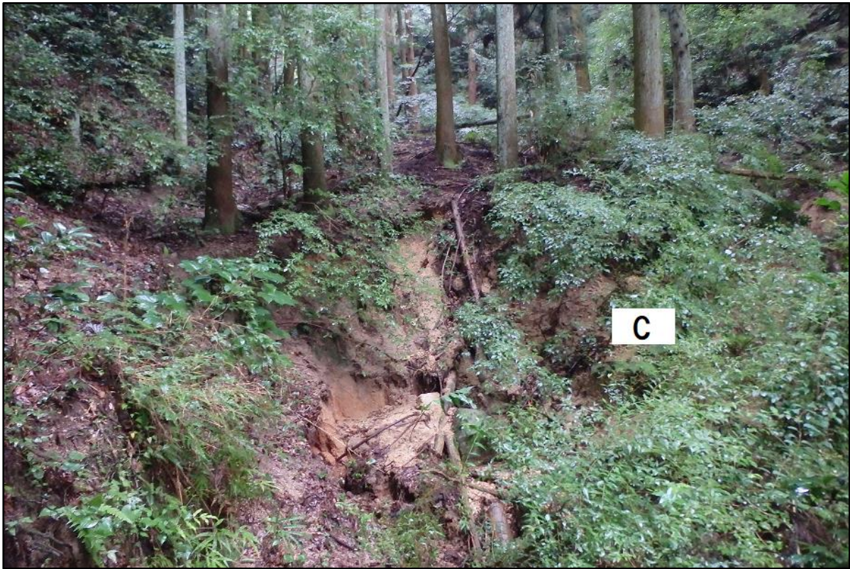
図 8-1. C 地点に見られる急傾斜の土砂崩壊箇所。大量の土砂が抜け落ちたように崩壊している。地下水圧が高まって起きるパイピング崩壊跡と考えられる。
