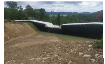
図4 新設の大型の治山ダム
