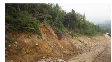
図7 壁の削剥と倒木
