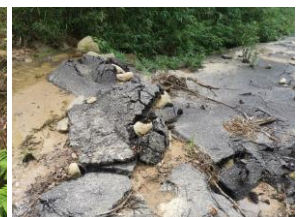
図13 舗装路を破壊
