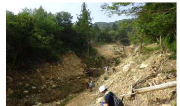
図6 ダムの破碎と両壁の侵食
