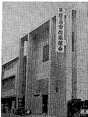
写真3 広島市信用組合同洋支店 (昭和34年竣工・現存)
