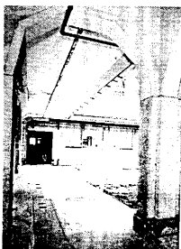
写真3 中庭廊下のアーチ
