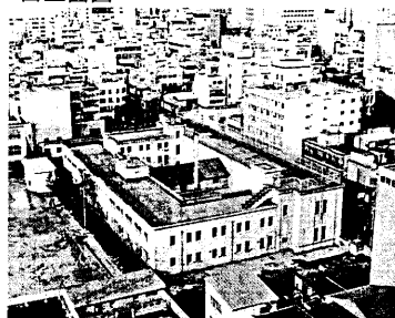
写真2 鳥瞰写真(解体前の全景)
