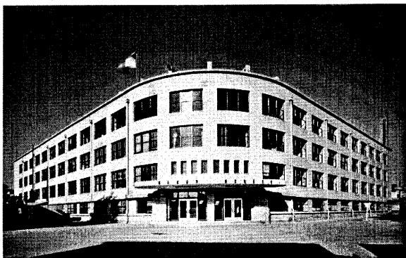
写真5 広島通信局庁舎外観（昭和8年竣工）
