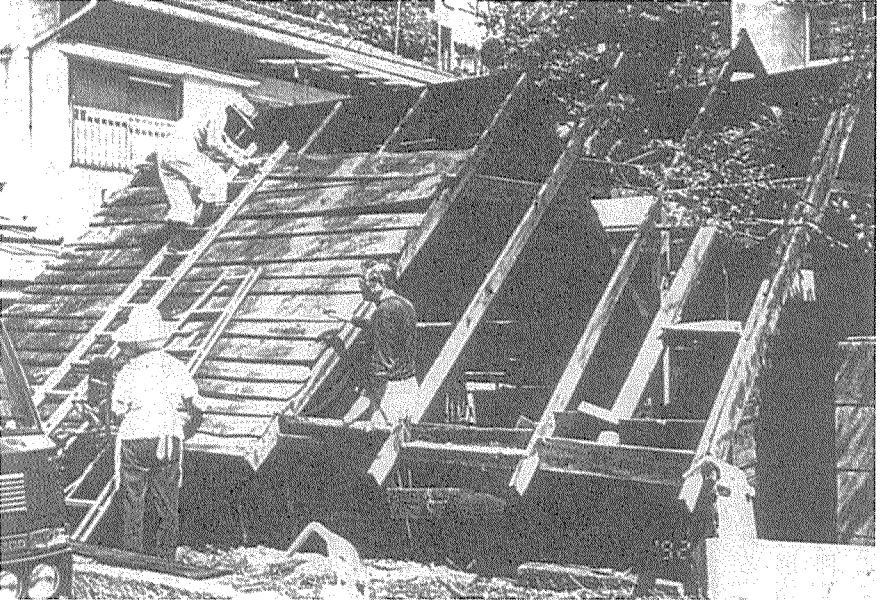
图3 屋根板撤去作業 平成4年9月16日
